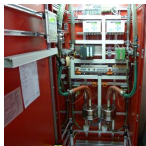
Obrázky: VisGuard miniextractive v SOS výklenku a extraktivní verze VisGuard Extractive v technické místnosti
